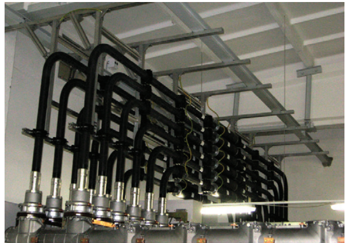
Подключение к ячейкам КРУ с изоляцией SF6 (элегаз)
