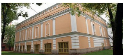
ПС Юсуповская, г. Санкт-Петербург
