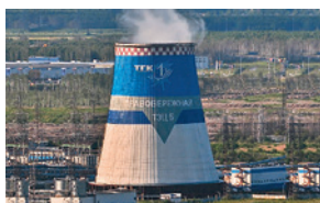
Правобережная ТЭЦ-5, г. Санкт-Петербург
