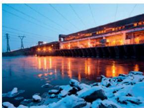
Новосибирская ГЭС, г. Новосибирск
