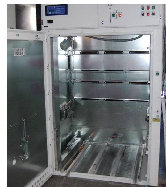
Коммутационный отсек
